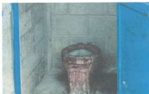
FOTO 4: SERVICIOS SANITARIOS Y SUS ACCESORIOS
