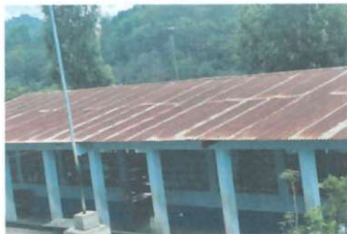
FOTO 3: CUBIERTA DE LÁMINA
