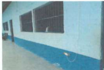
FOTO 1: PINTURA EN MUROS INTERIOR Y EXTERIOR
