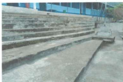
FOTO 5: REPARACIÓN DE REPELLO Y CERNIDO DE GRADAS
